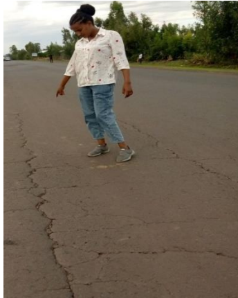
Longitudinal Crack
